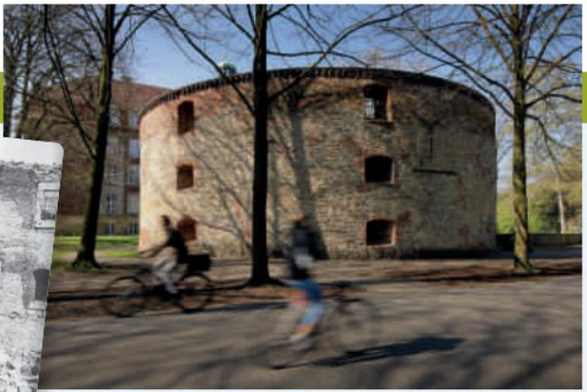
*Eine Geschichte mit Brüchen ist auch an den Mauern des Zwingers ablesbar: deutliche Risse nach den Erschütterungen des 2. Weltkriegs und Materialwechsel als Teil der Baugeschichte.*
